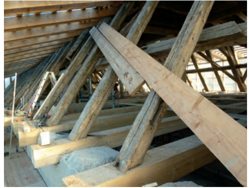
Sanierung eines historischen Dachstuhls
